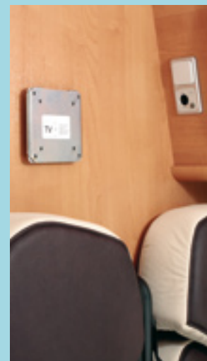
Pré-câblage et support TV.
