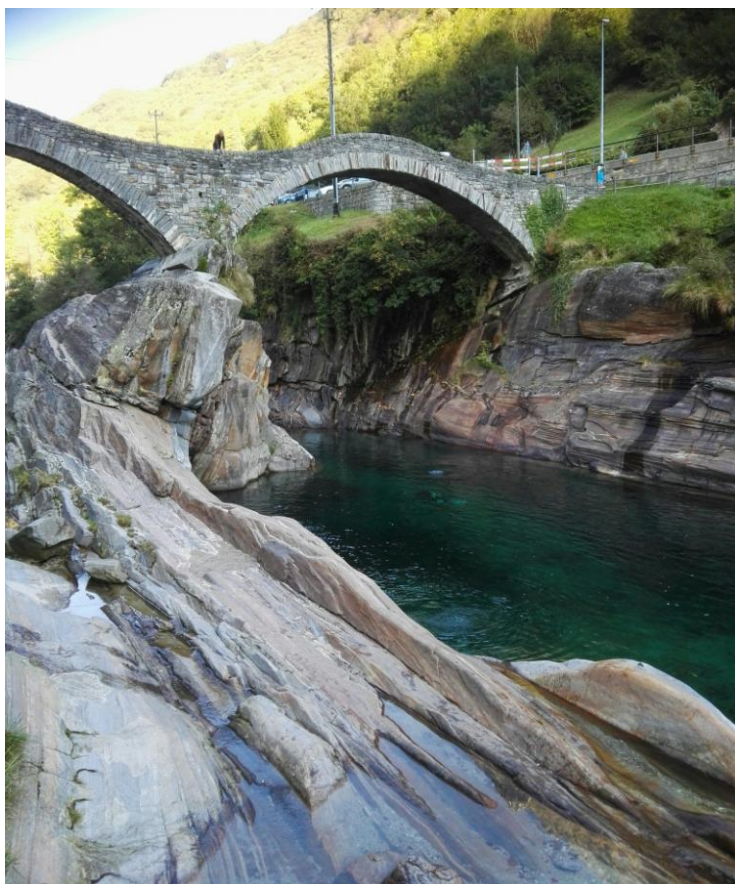
LAVERTEZZO PONTE DEI SALTI
