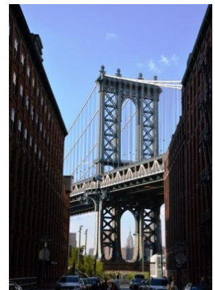
NY: il Manhattan Bridge visto da Washington Street.
