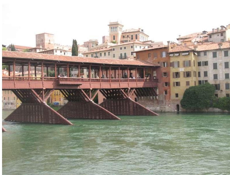
Bassano del Grappa (VI)-Ponte degli Alpini
