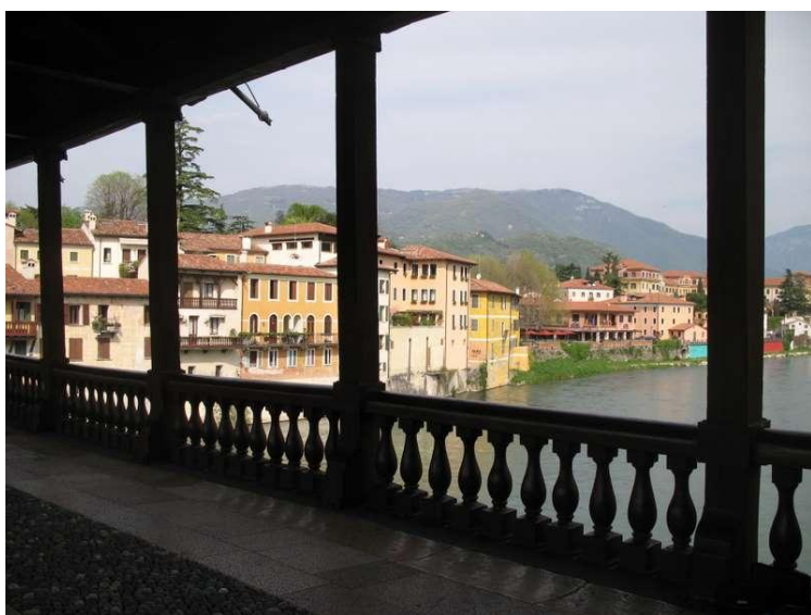
Bassano del Grappa (VI)-Ponte degli Alpini
