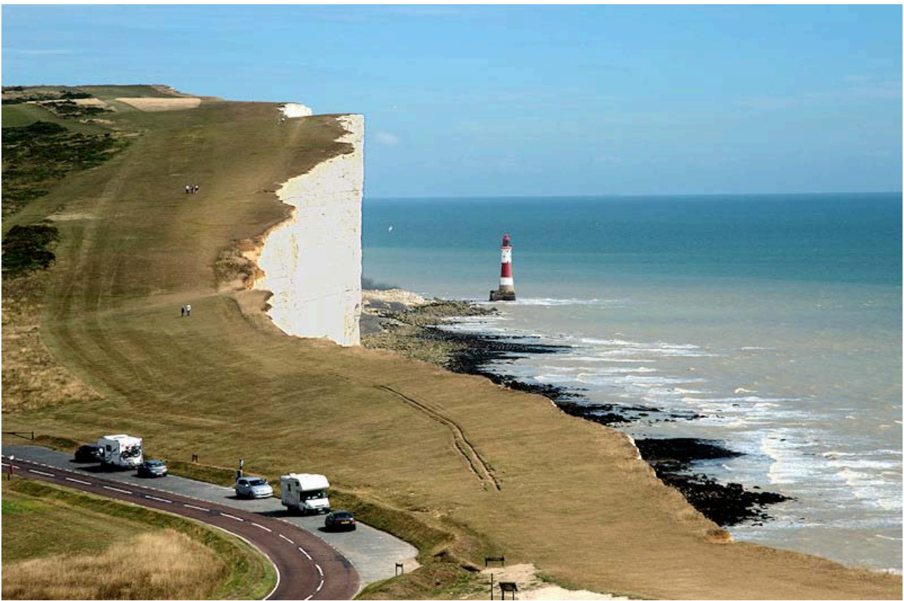
Parcheggio (a pagamento, ovviamente “no overnight”) presso Beachy Head
