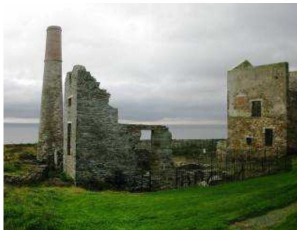
Copper Cost Vecchia miniera di rame
