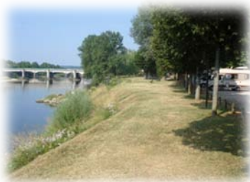
Parcheggio lungo il fiume a Pont D'Ain
