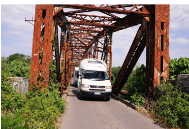
Un ponte lungo la via
