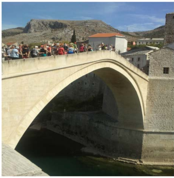
Il vecchio ponte ora ricostruito. Fu costruito nel XVI sec. Con la caratteristica detta a "schiena d'asino"
