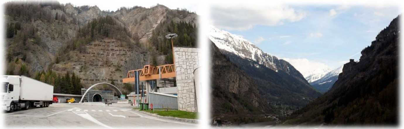
Tunnel del Monte Bianco
