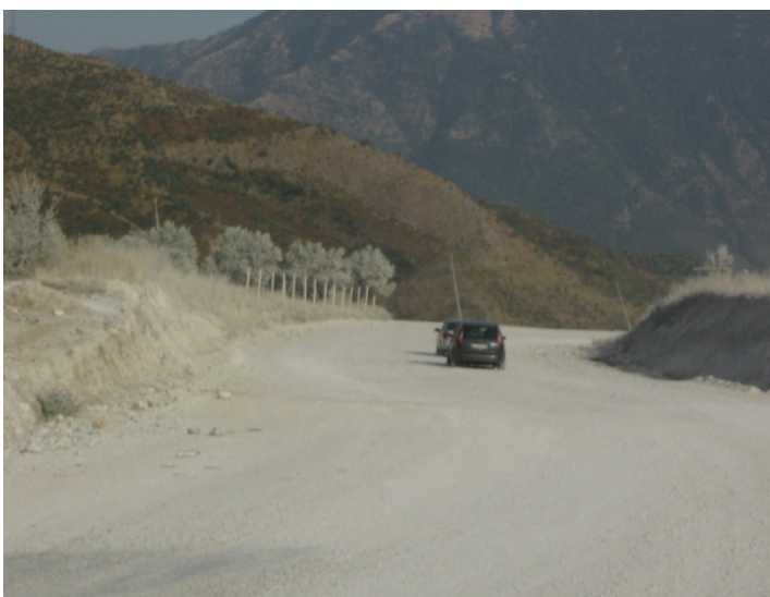
(Tratto di strada in costruzione tra Fier e Giirocastro)
